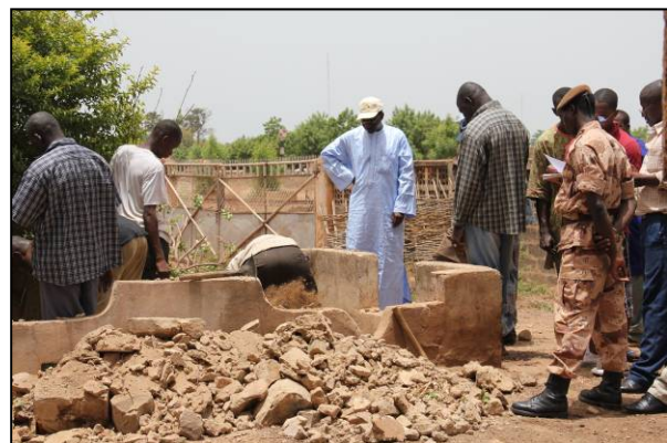
Début des travaux d'exhumation - 16 mai 2011
